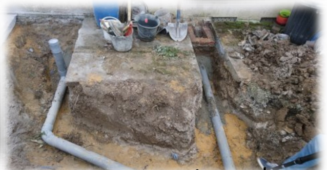
Travaux d'assainissement de mise en conformité
